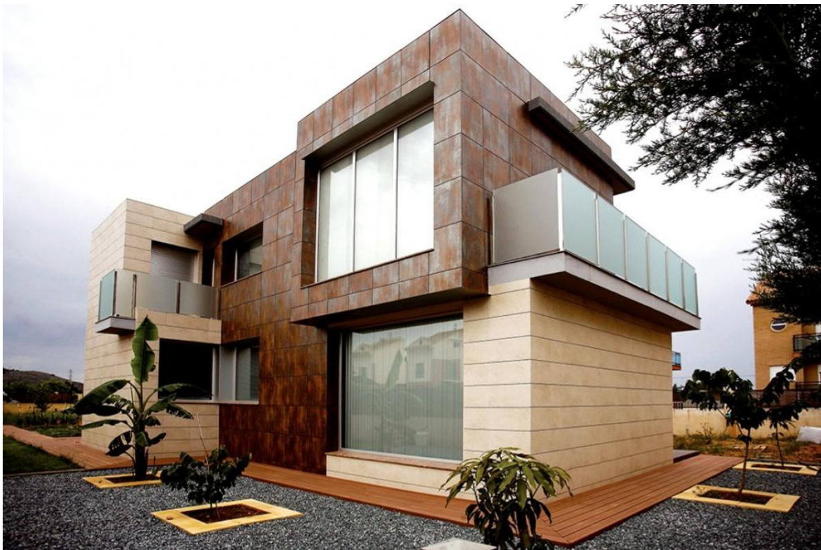
Рисунок 5 – Пример вентилируемого фасада из керамогранита
